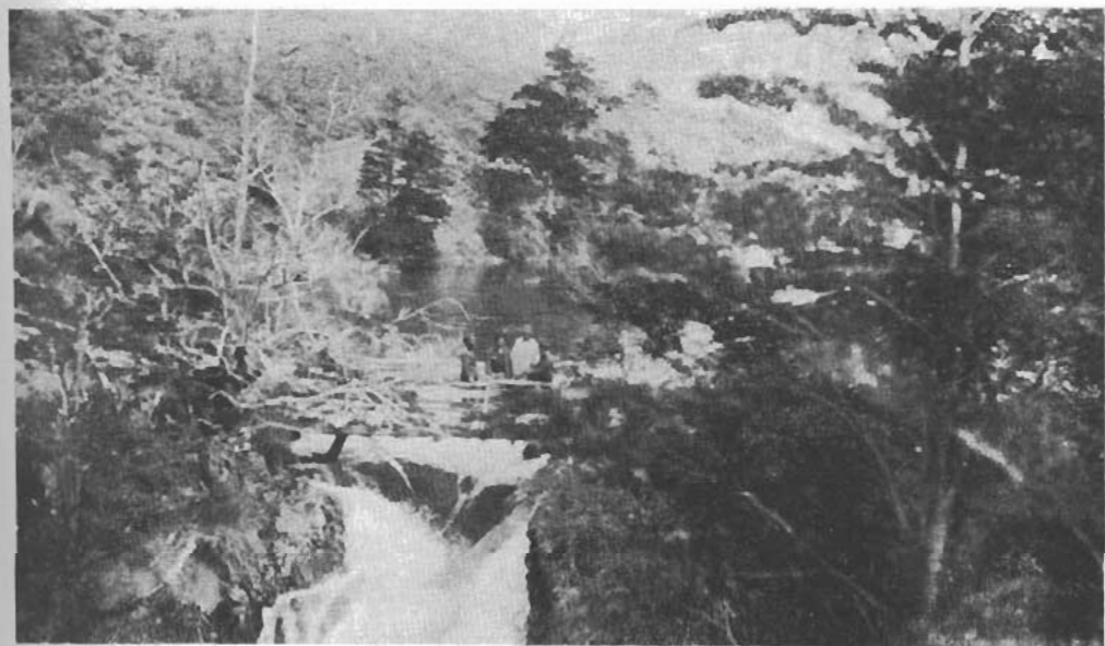
PUENTE SOBRE EL RIO COCHRANE.
