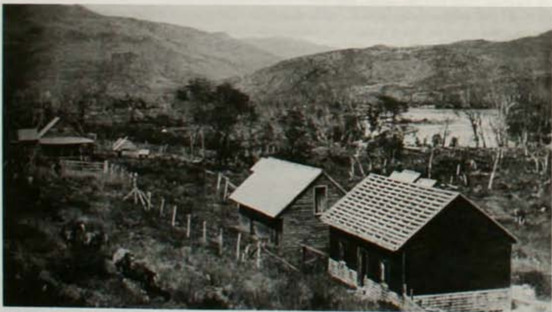
Otras casas del casco de la estancia Baker en 1911. Obsérvese los detalles de construcción.
