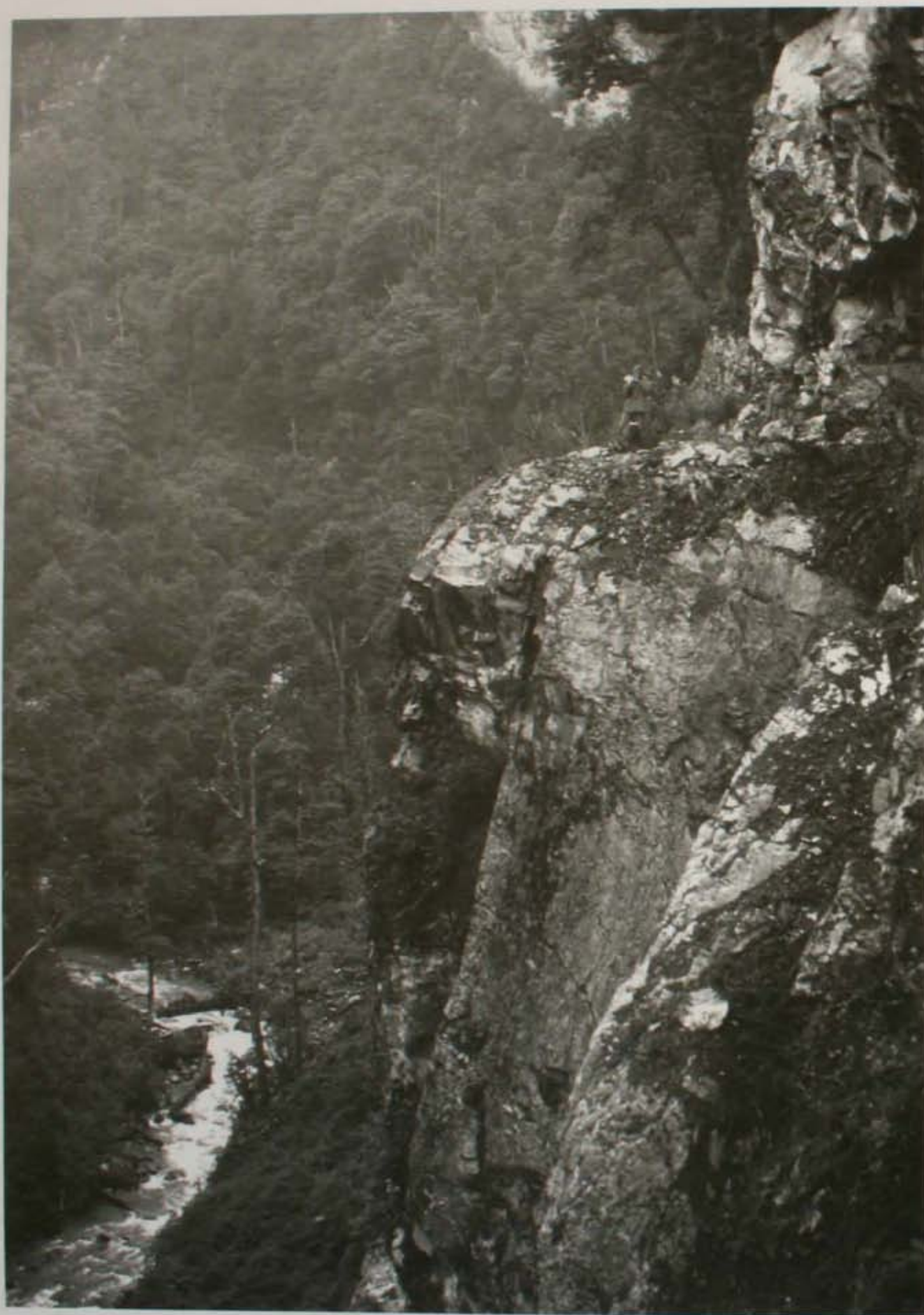
El acantilado del sector El Vagabundo, en el valle fluvial del Baker, fue uno de los tramos más difíciles de superar en la sección sur de la Carretera Austral.
