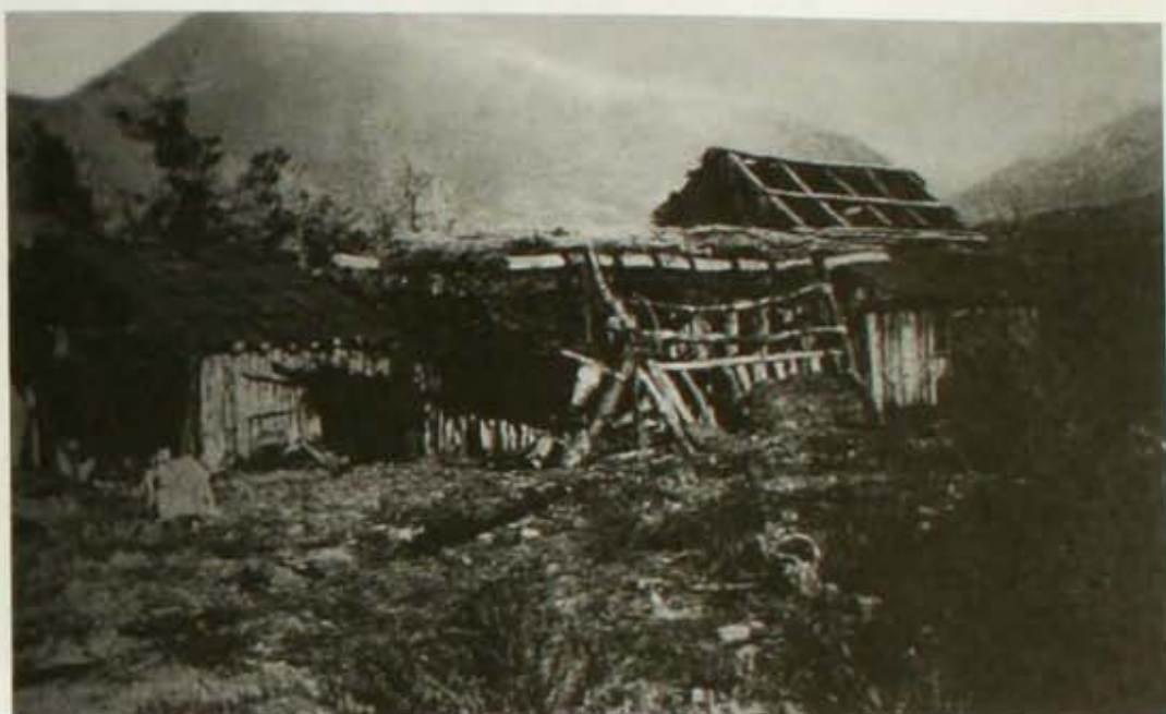
Construcciones de un poblador en la zona del Baker, 1911.
