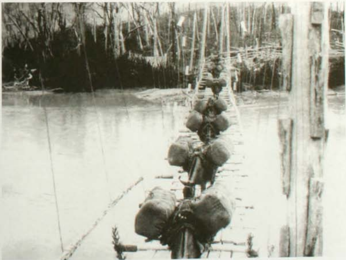
Recua de mulas cargadas con fardos de lana, cruzando el río Ñadis por un puente colgante. Fines de los años de 1920. Obsérvese el aparejo de transporte y el tamaño de los fardos, ideado por Lucas Bridges para hacer posible el traslado de la lana desde la estancia Baker hasta el puerto de Bajo Piragua.
