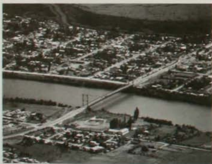
Vista del puente "Presidente Carlos Ibáñez del Campo" sobre el río Aysén.
