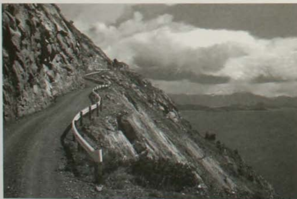
Vista del corte en roca que debió hacerse para superar El Paso de las Llaves, el tramo más difícil de ejecutar en el camino que une Chile Chico con Fachinal.
