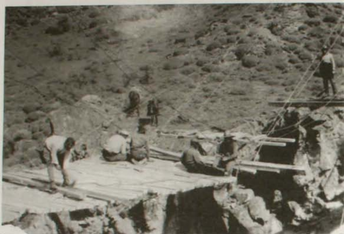
Puente en construcción bajo la dirección de Lucas Bridges, en la senda entre el valle Chacabuco y el valle inferior del río Baker. Década de 1920.
