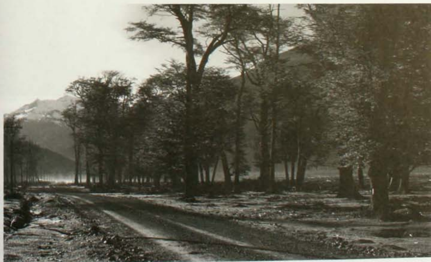
Aspecto de la Carretera Austral en la sección comprendida entre el fiordo Michell y el lago O'Higgins.
